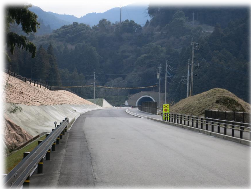
八丁峠トンネル付近
