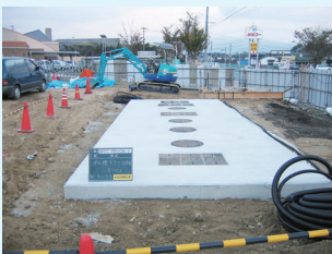
浄化槽工事の様子
