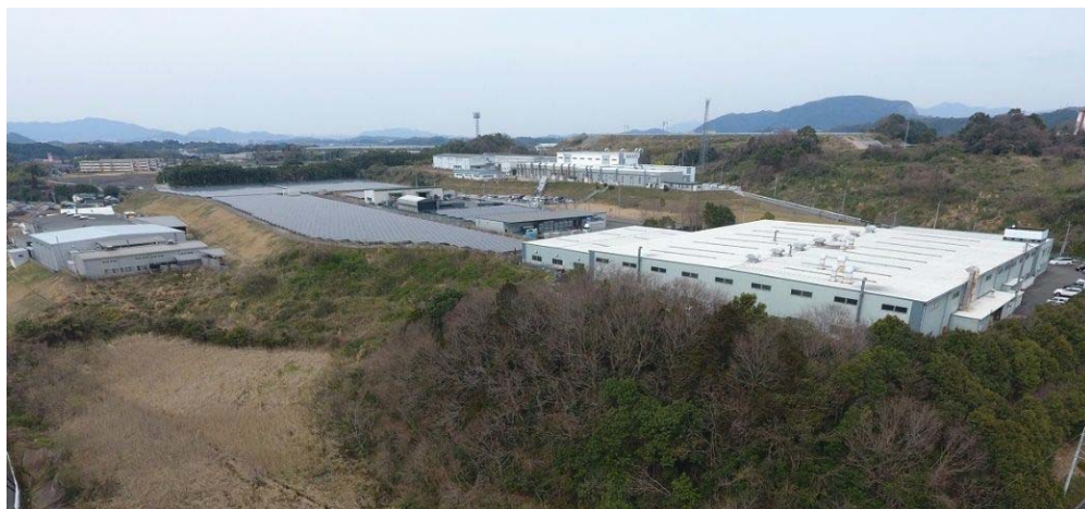
漆生工場団地
