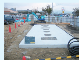
浄化槽工事の様子
