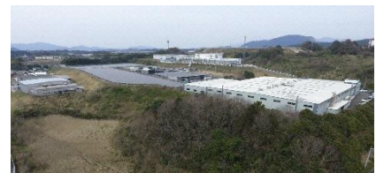
漆生工場団地
