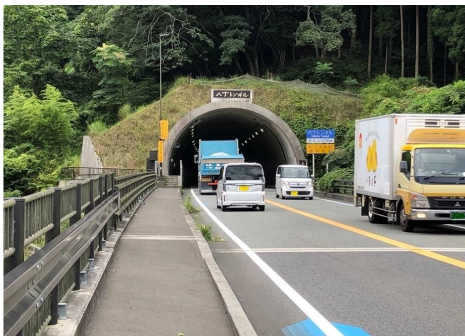
八丁峠トンネル付近
