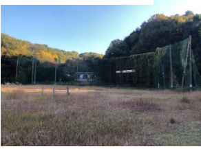
《バックネット》 (解体前)
