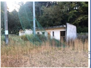
《クラブハウス棟、倉庫》 (解体前)
