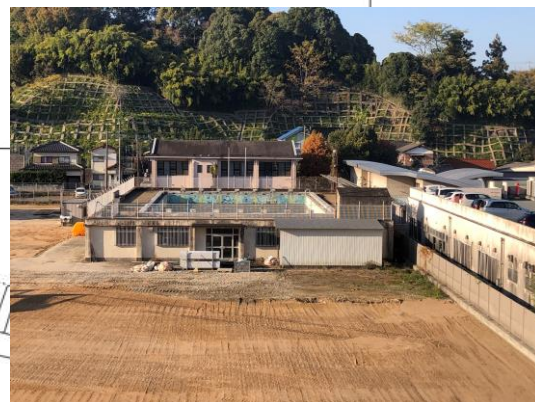
《プール棟》 (解体前)
