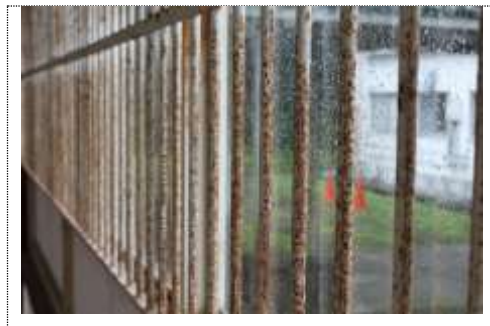
（ 体育館内側窓 ）
