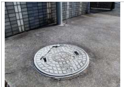
（ トイレ便槽蓋 ）
