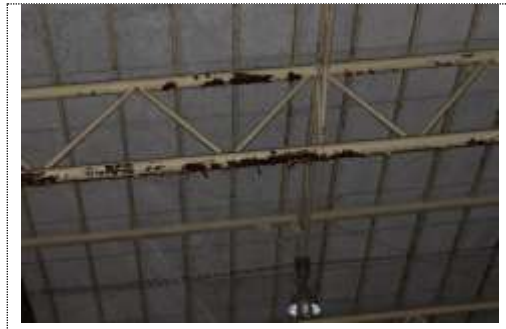
（ 体育館内天井 ）
