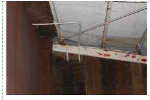
（ 体育館内用具室天井 ）
