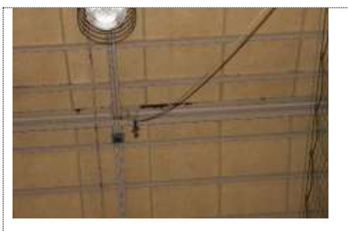
（ 体育館内天井 ）
