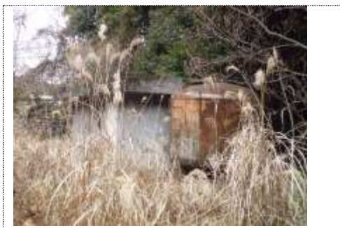
（機械室・貯水タンク）
