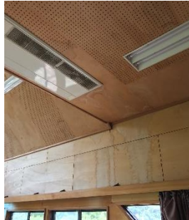
都市と農村交流室（天井・雨漏り跡）
