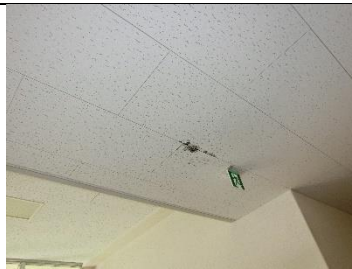
2階・廊下天井（漏水跡・カビ）
