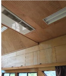
都市と農村交流室（天井・雨漏り跡）
