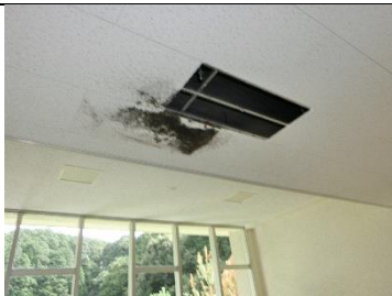
2階・廊下天井（漏水跡・カビ）
