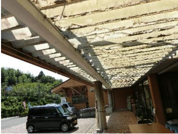
雨樋が小さく、雨水を吐ききれない。
