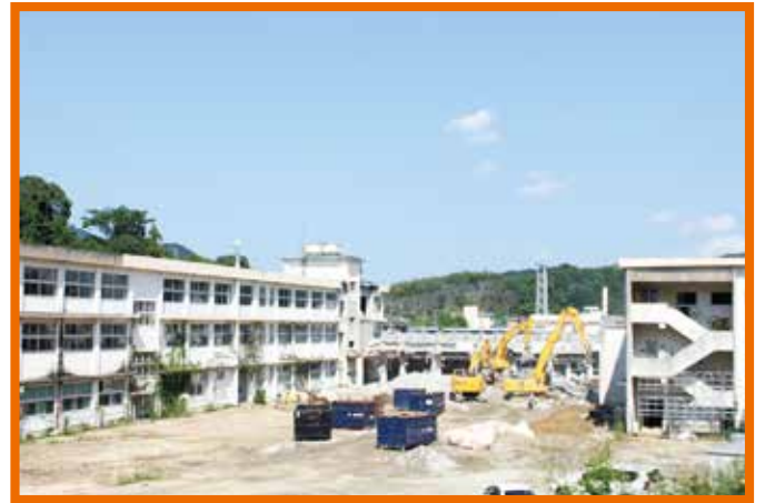
▲解体工事の様子
