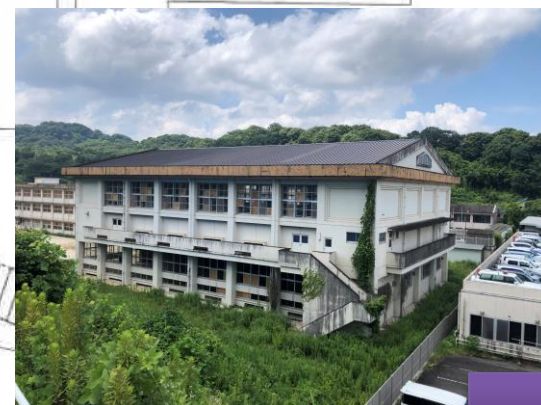
《体育館棟》 (解体前)
