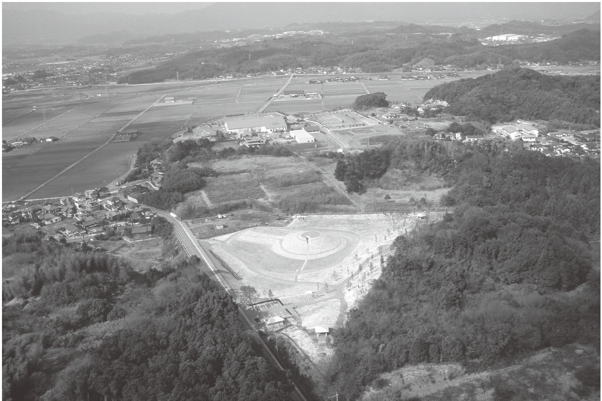
① 復元整備された沖出古墳1（平成15年竣工時）
