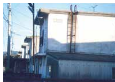
▲老朽化した改良住宅
