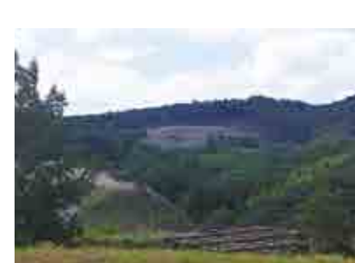
百々谷中間処分場
