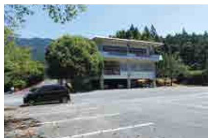
熊ヶ畑分館と駐車場
