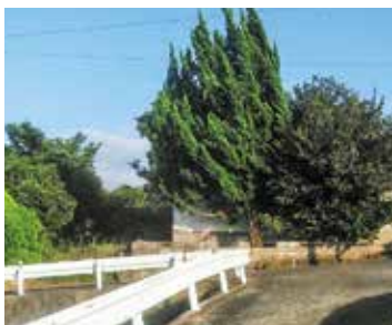
雑草の生茂った空き家
