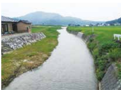
土砂堆積（千手川）
