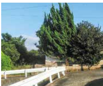
雑草の生茂った空き家
