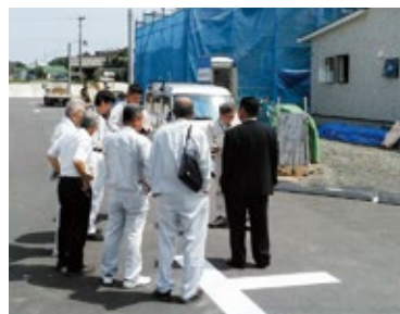
現地調査の様子
